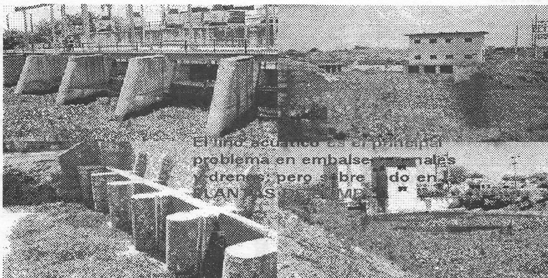
Foto 1. El lirio acuático en el DR 024 ocasiona severos problemas a las plantas de bombeo al taponear las rejillas de los cárcamos y los canales de llamada.
